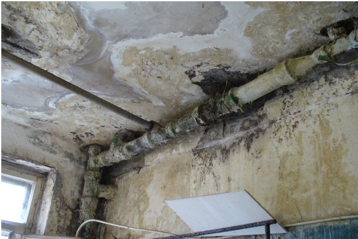
5.20. Постоянное увлажнение перекрытий за счет отсутствия вентиляции в помещениях с влажной средой, в т.ч. за счет протечек коммуникаций
