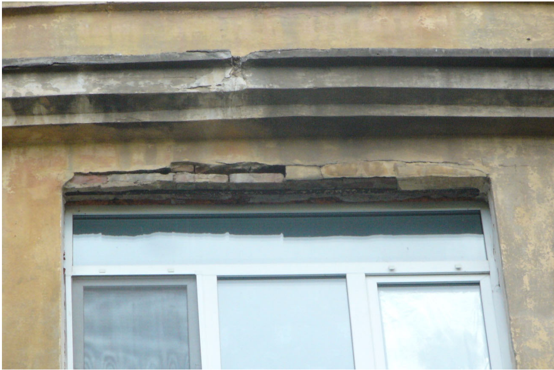
Фото 11. Разрушение защитного слоя рядовых перемычек, коррозия и нарушение анкеровки арматуры. Разделение пояса кладки над перемычкой. Опасность выпадения кирпичей.
