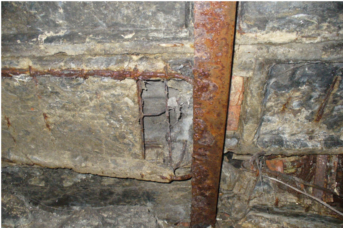
Фото 24 Полное разрушение железобетонного покрытия входной группы подвала у оси Л' . Опасность обрушения.
