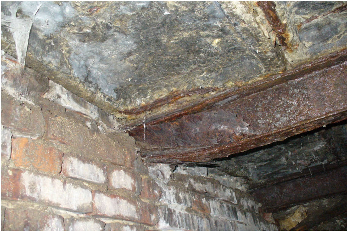
Фото 25. Коррозионное разрушение стальной балки покрытия над входной группой подвала у оси Л'. Опасность обрушения.
