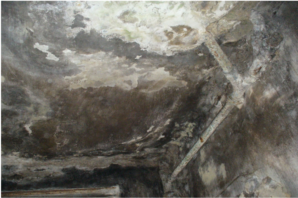
5.21. Поражение бетона перекрытий черным грибком
