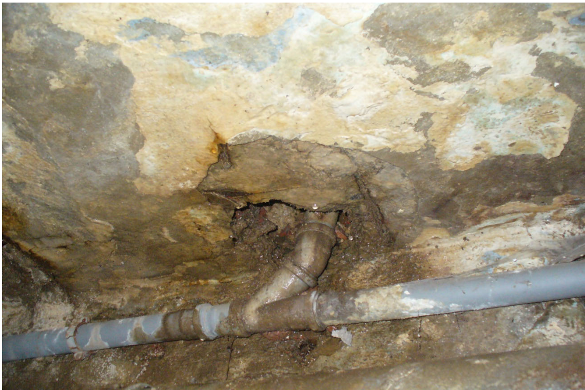
Фото 19. Разрушение защитного слоя, коррозия рабочей и конструктивной арматуры.
