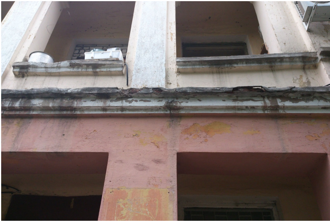
Фото 9. Разрушение защитного слоя, коррозия арматуры железобетонных элементов выносных карнизов фасадов
