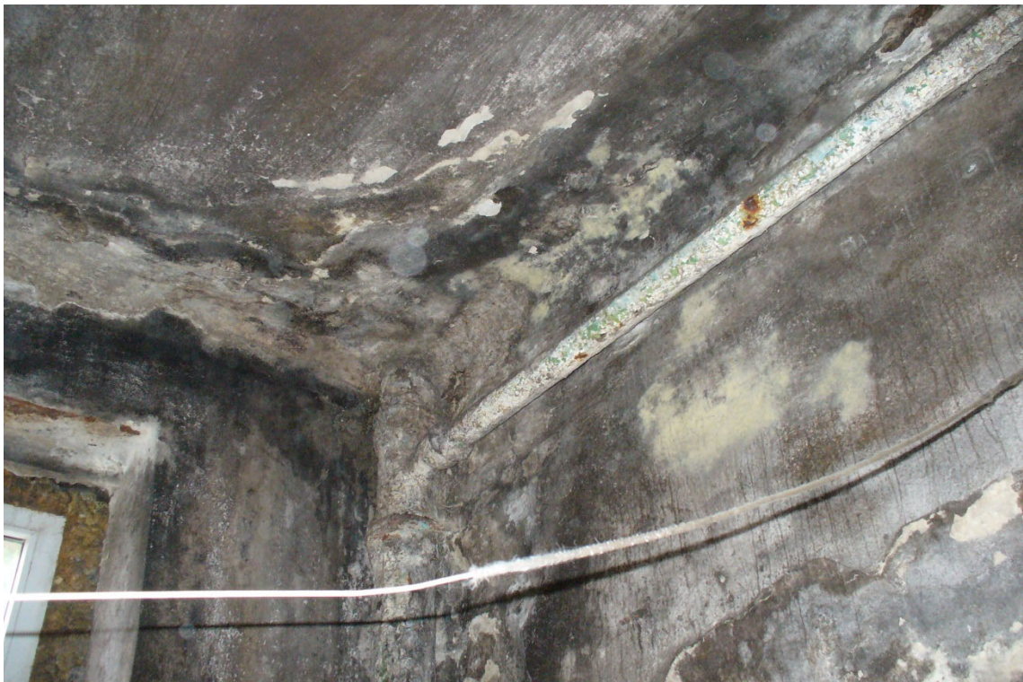
Фото 18. Поражение штукатурного слоя и кладки грибком в душевых
