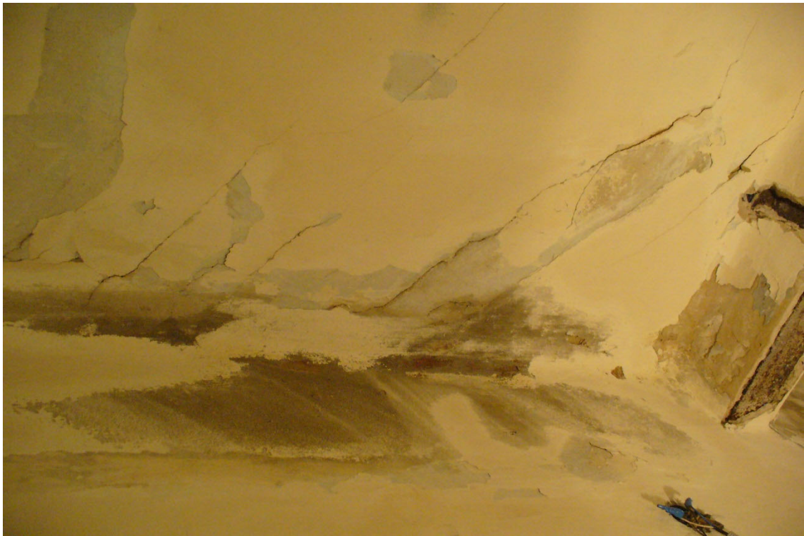
Фото 26. Диагональные трещины в штукатурном слое деревянных перекрытий.
