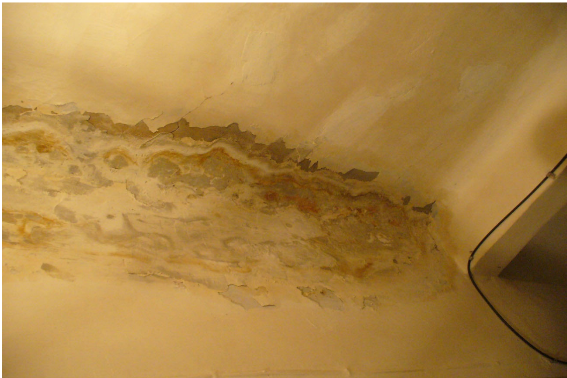
Фото 27. Интенсивные потеки на нижней поверхности перекрытий, свидетельствующие о постоянном их увлажнении
