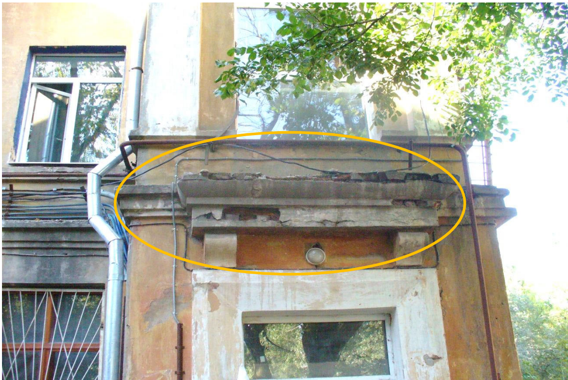
Фото 10. Размораживание кладки и выветривание швов приводит к расшатыванию камней и растворной постели, при этом создается опасность отпадения камней и фрагментов кладки
