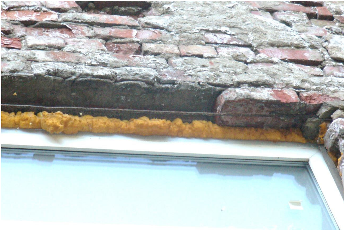
Фото 12. Полное разрушение рядовых перемычек, выпадение кирпичей
