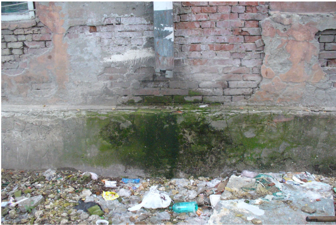
Фото 13. Систематическое увлажнение цоколя. Биологическое поражение штукатурного слоя и кладки. Захламление участка у стены строительным и бытовым мусором.
