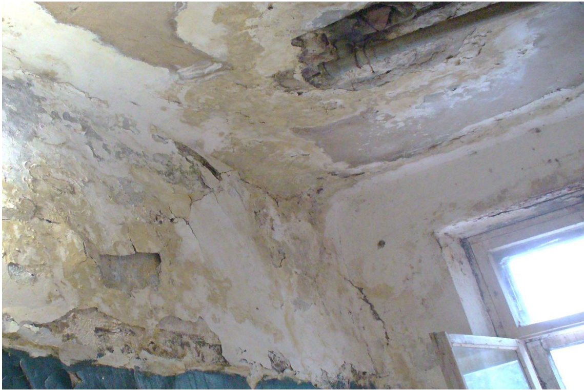
Фото 17. Разрушение штукатурного слоя и поверхностного слоя кладки, внутренних стен в санузлах опасность отпадения фрагментов штукатурного слоя.
