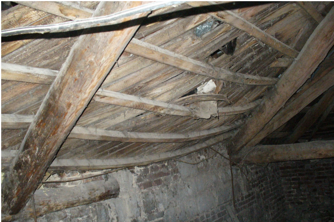
Фото 34. Прогиб обрешетки под нагрузкой от двойной кровли в осях Л'-5'
