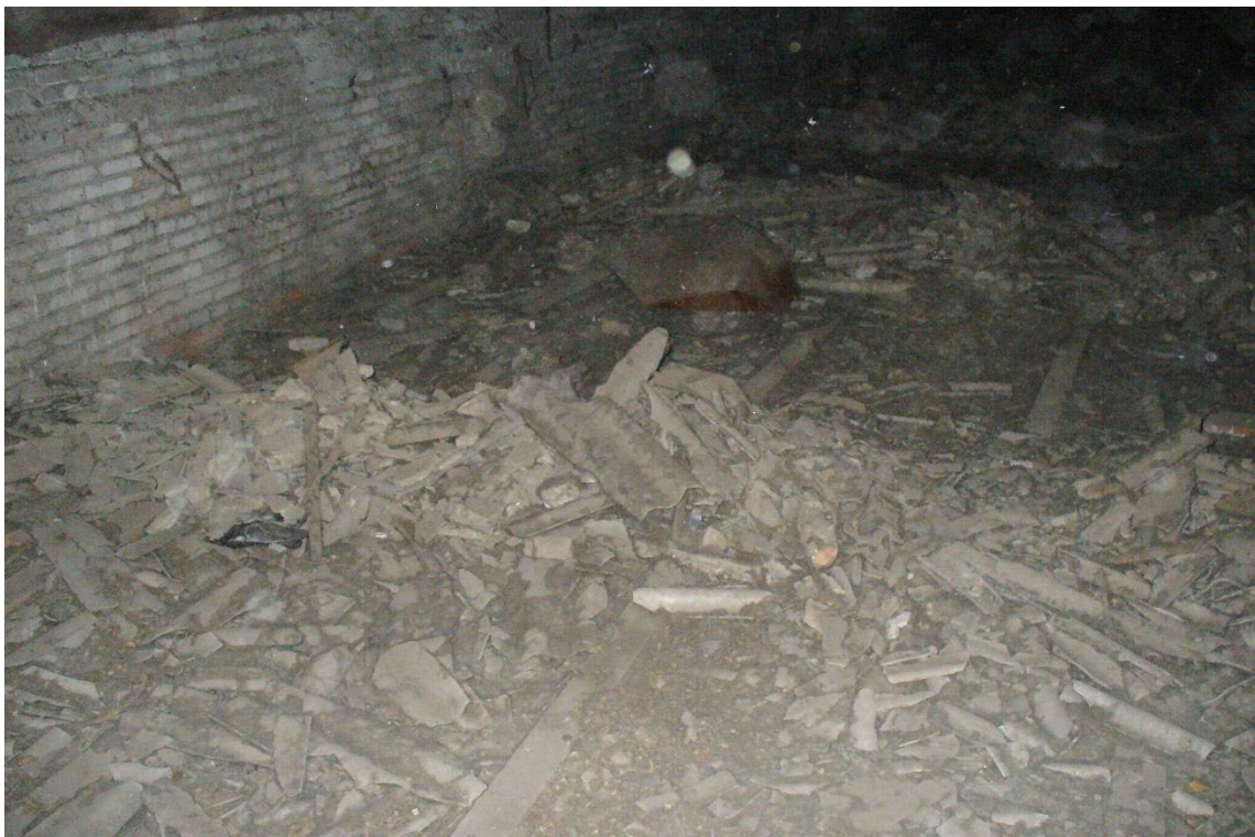
Фото 32. Повсеместное захламление чердачного перекрытия строительным мусором.
