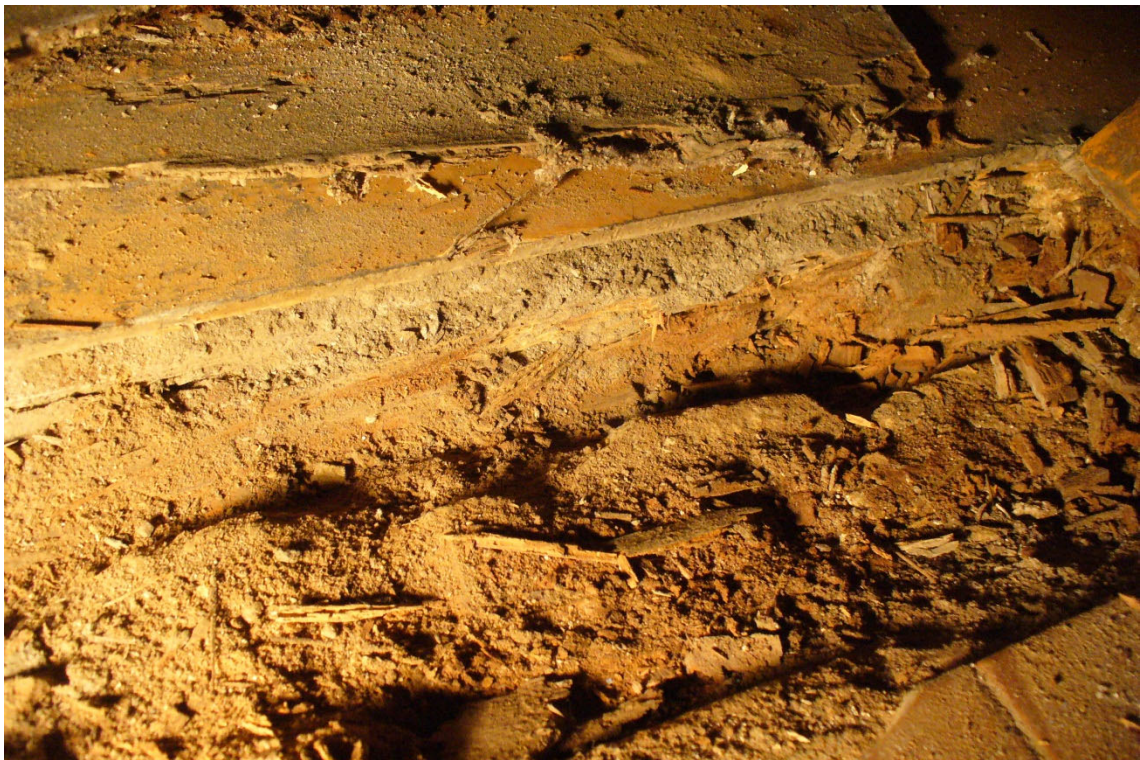
Фото 29. Поражение гнилью (грибком) пола и балок перекрытия, примыкающих к санузлам.
