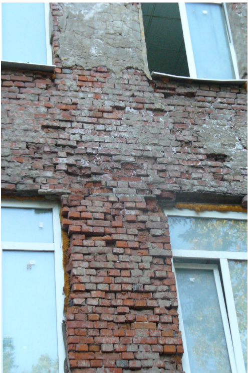
Фото 7. Глубокое размораживание кладки наружных стен помещений санузлов и душевых.
