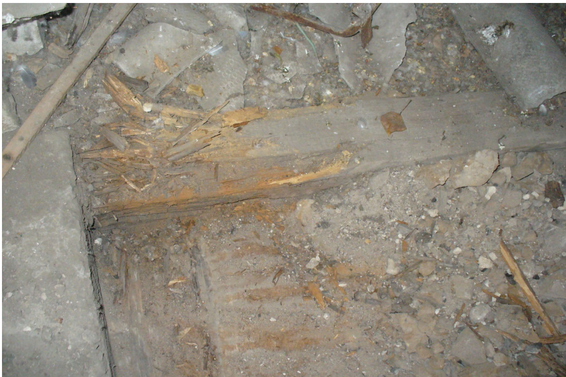
Фото 30. Поражение балок чердачного перекрытия и наката в осях Б-К гнилью.
