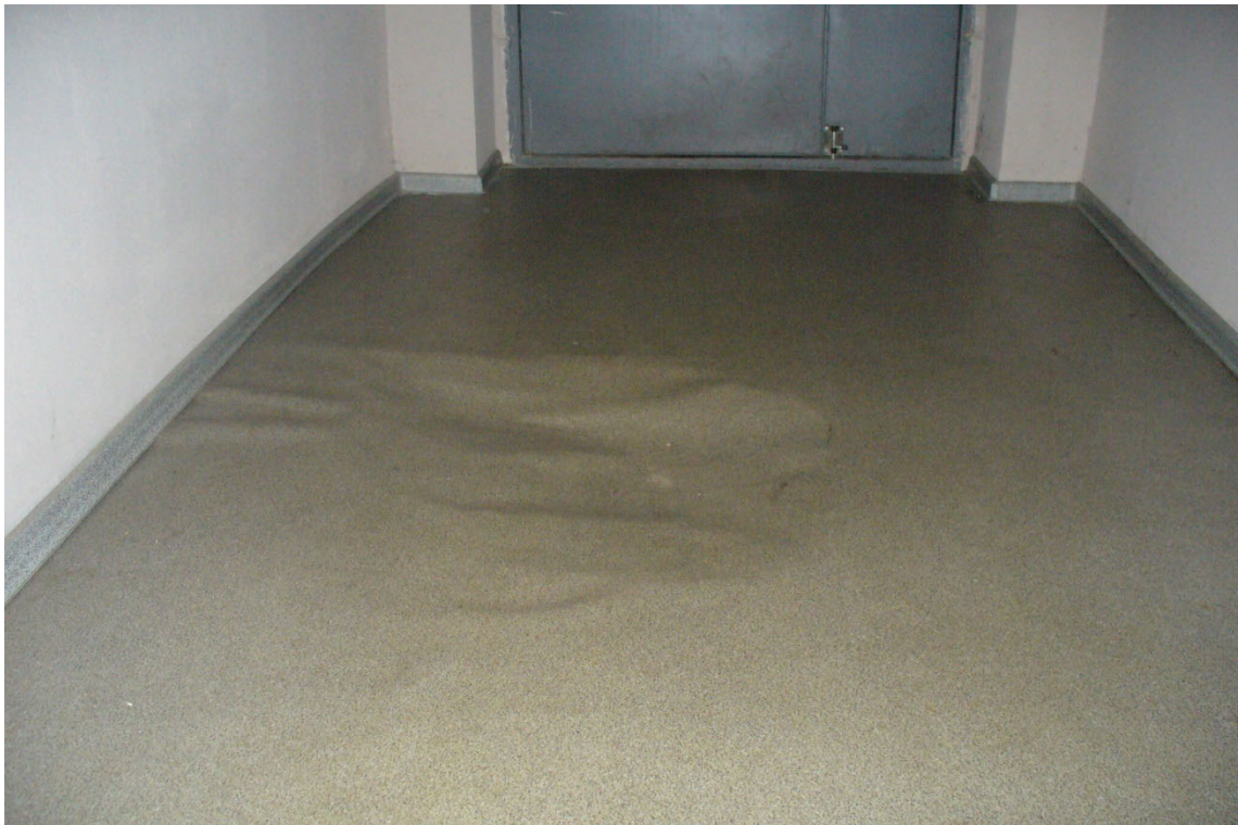
Фото 28. Провалы в полах в осях Л-М
