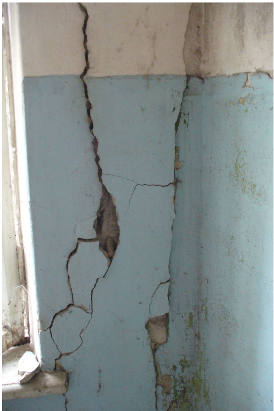
Фото 16. Разрушение простенков в стыке блоков здания по оси «3» (вид со стороны помещений)
