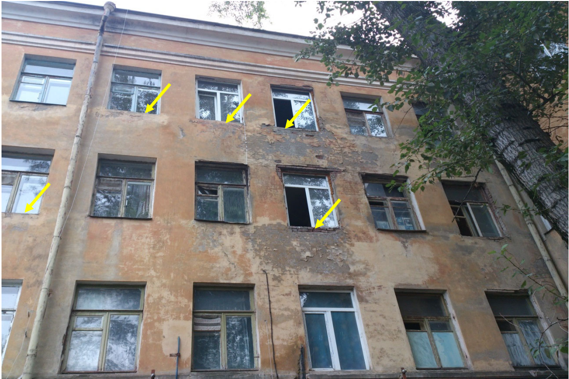
Фото 4. Отсутствие подоконных отливов на фасаде в осях К-Г.
