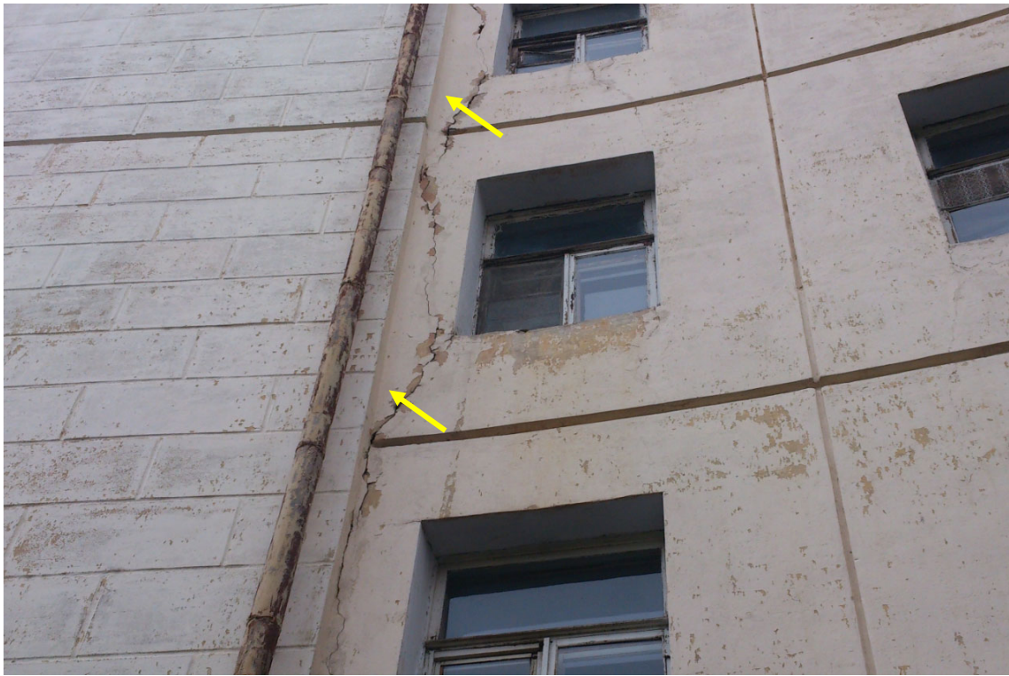
Фото 15. Конструктивно неверное оформление деформационных швов в стыке блоков здания по оси «3» приводит к разрушению кладки простенков наружных стен
