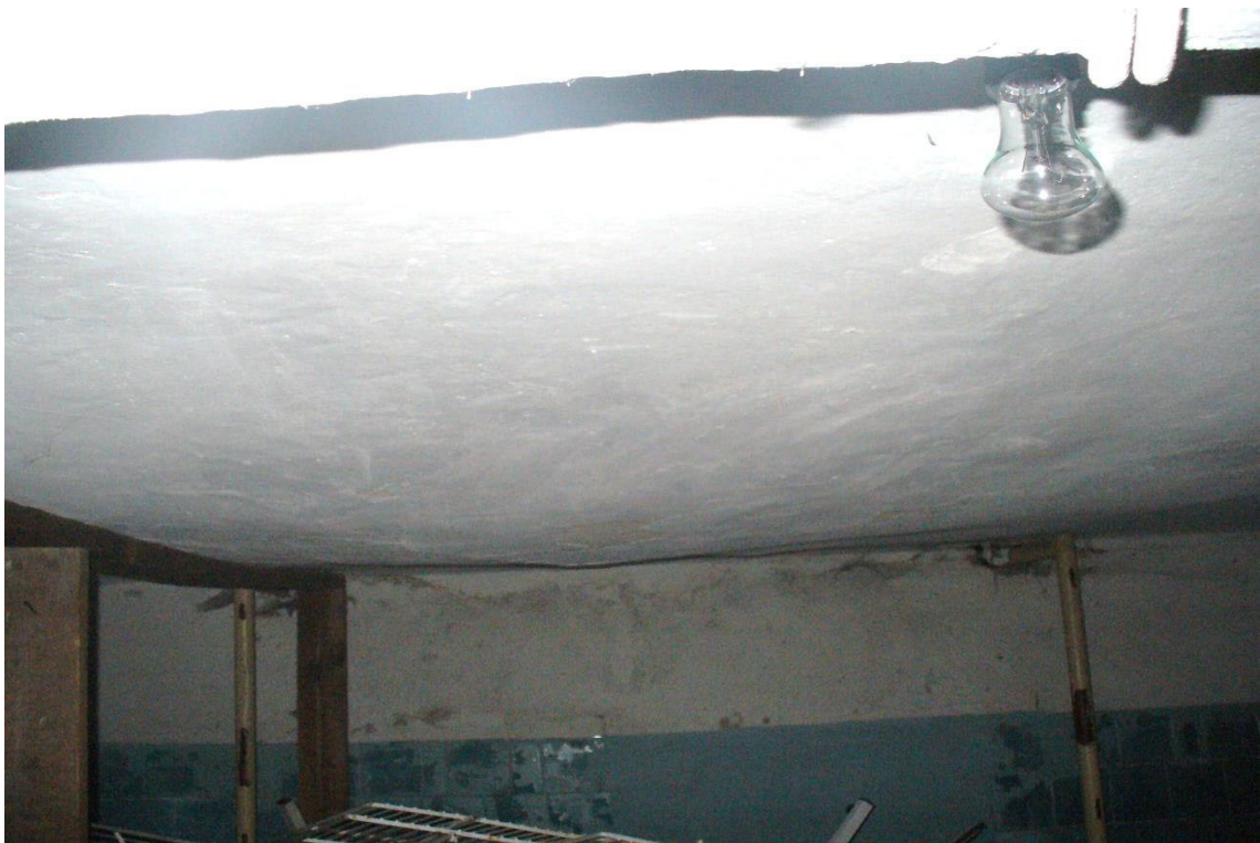
Фото 23 Провисание перекрытия подвала в осях Л'-5' на отдельных участках.
