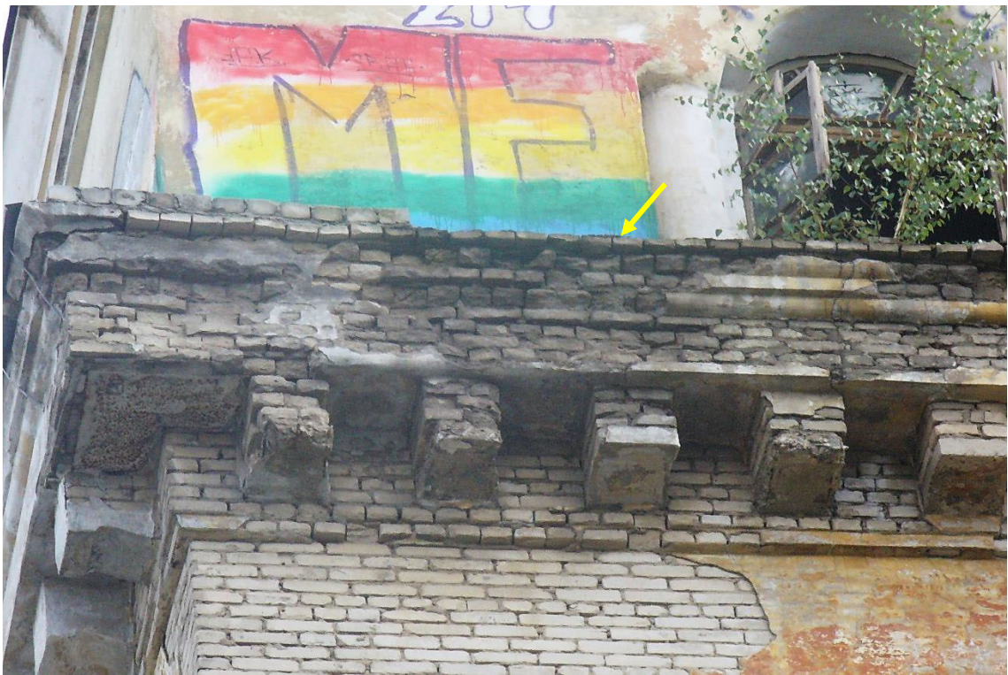
Фото 2. Отсутствие отливов и фартуков на выносном карнизе башни в осях 4-5.
