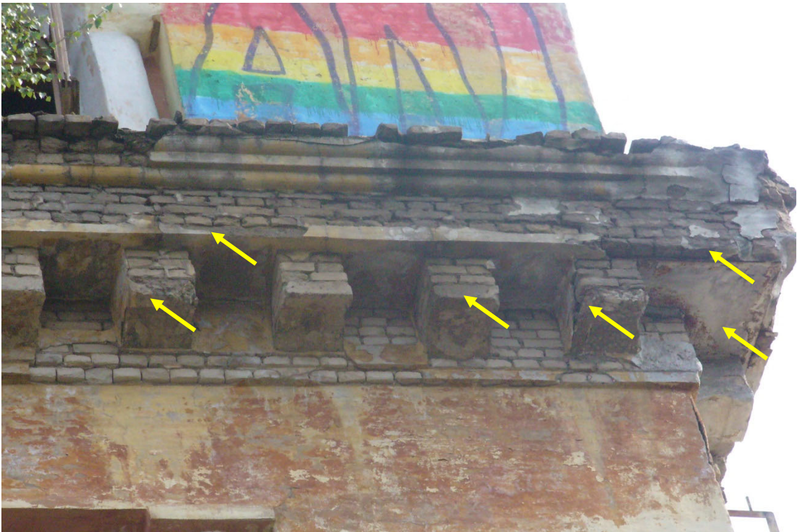
Фото 8. Размораживание железобетонных элементов карнизных участков стен в осях 4-6 в результате систематического интенсивного увлажнения
