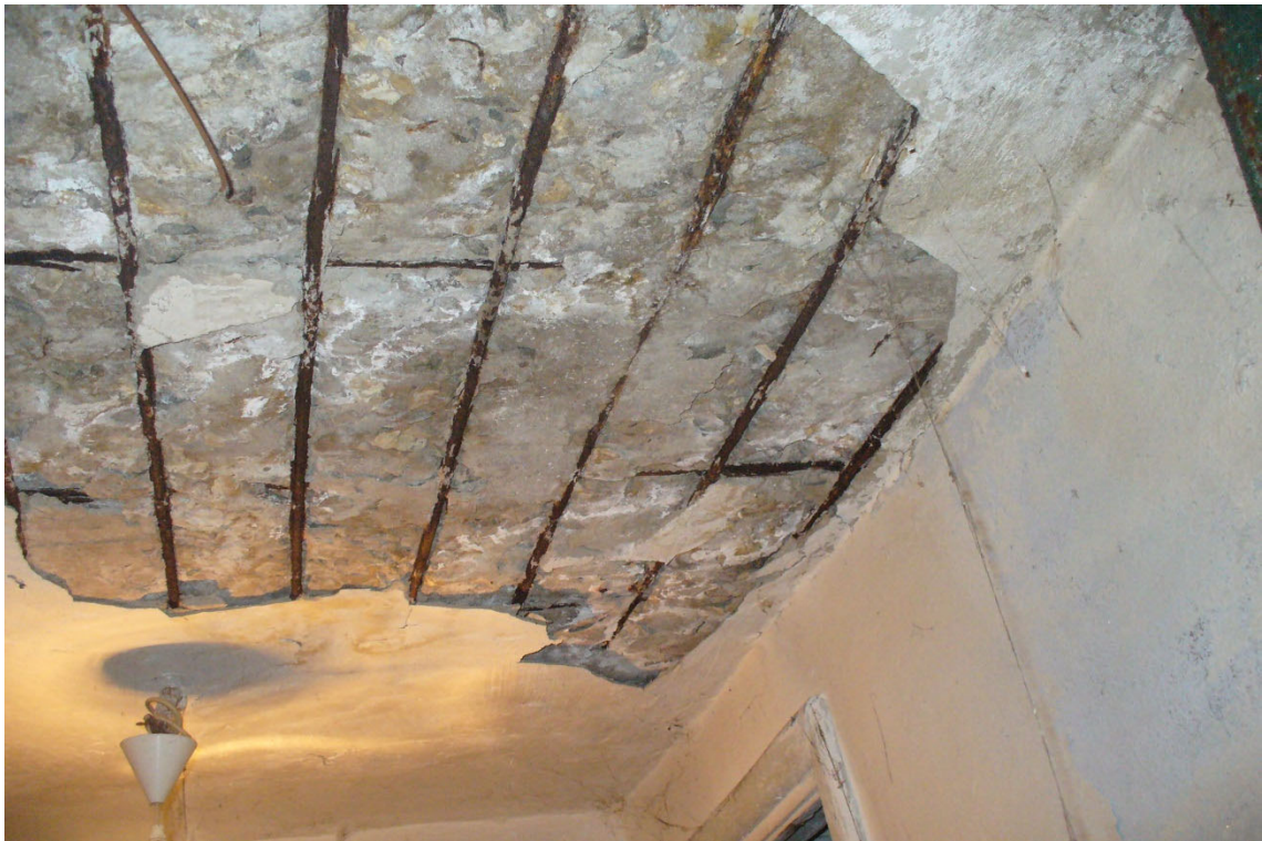
5.22. Коррозионные повреждения арматуры перекрытия подвала в осях А-Г/9-10, отпадение защитного слоя, как результат накопления продуктов коррозии на поверхности арматуры.
