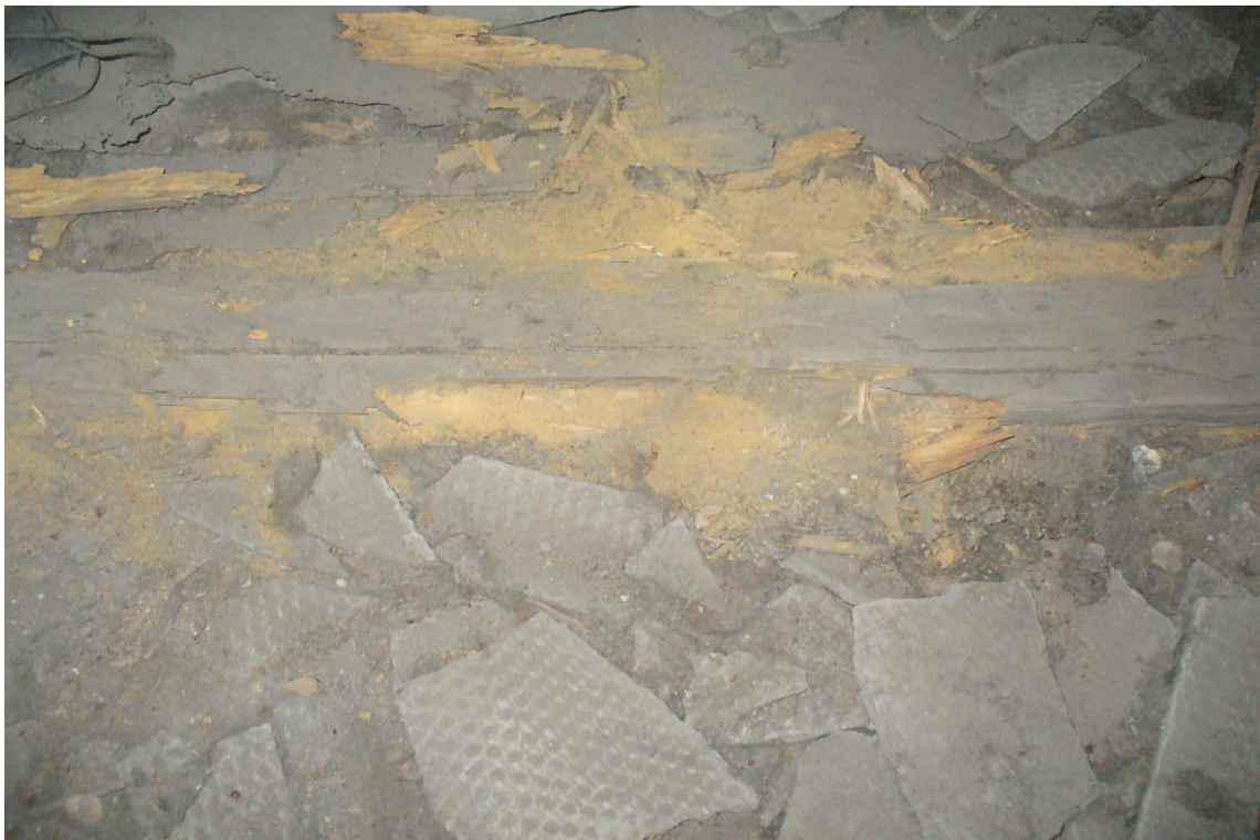
Фото 31. Глубокое поражение балок чердачного перекрытия в осях 6-9 древесными точильщиками
