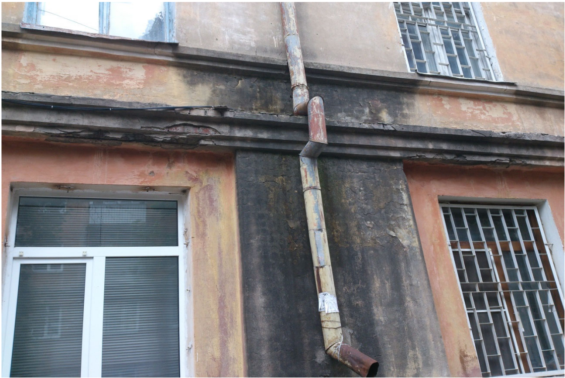
Фото 5. Интенсивное увлажнение кладки, поражение штукатурного слоя грибком
