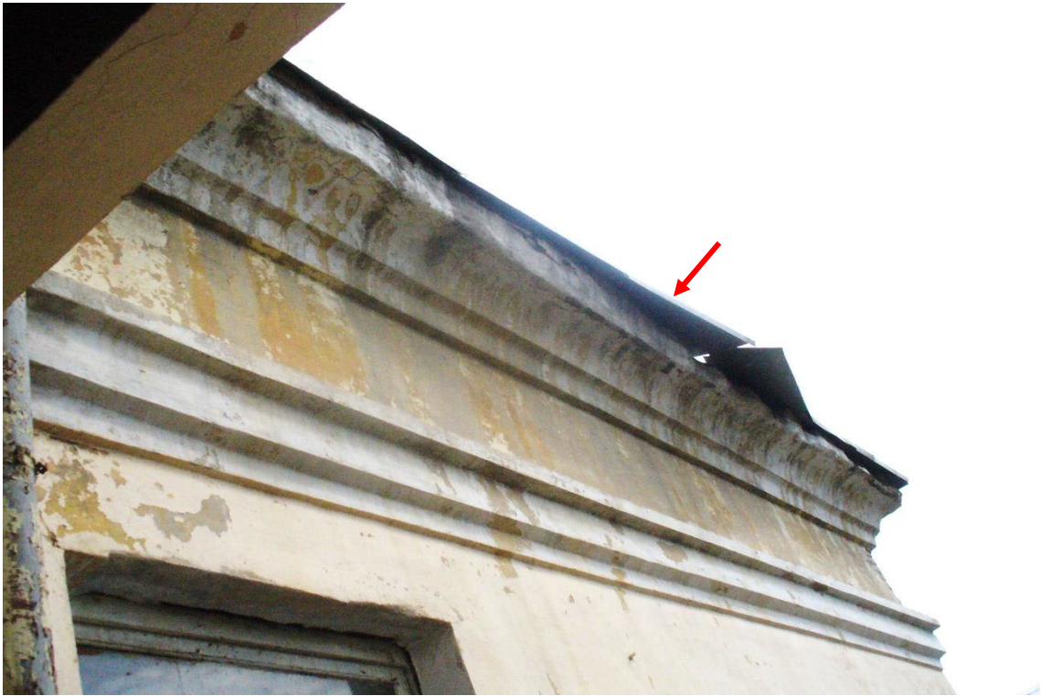
Фото 3. Расстройство и коробление отливов стены в осях 10-11.
