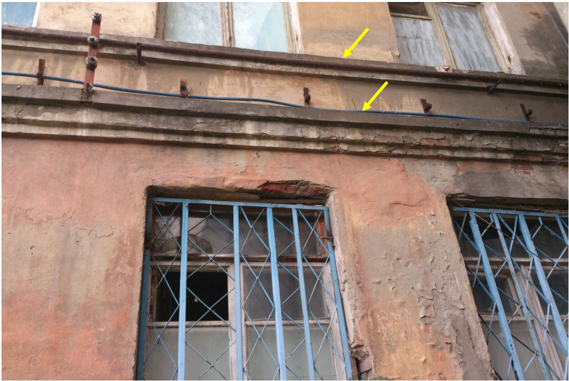
Фото 1. Отливы на выносных карнизах наружных стен отсутствуют
