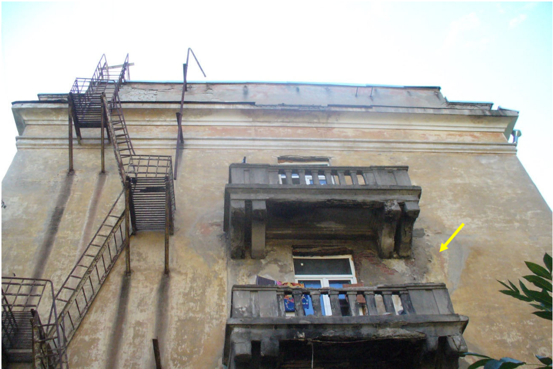
Фото 6. Интенсивное увлажнение стен в области балконов
